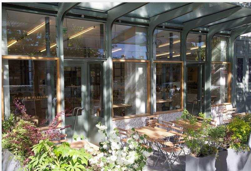
Profil acier à rupture thermique classé RT 2012, 100% recyclable assurant une isolation performante avec une largeur de profilés extra fine. ( GAMME ARTE DE CHEZ JANSEN )
